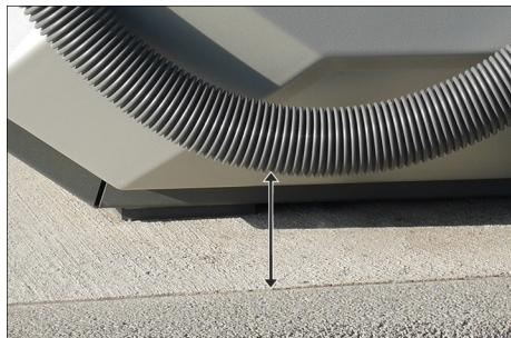
→ Šķūtenes garumu pielāgot uz vietas. Ar iekārtu automašīnas sprauslu sūkšanas šķūtenes apkalpes sist. nedrīkst gu-lēt uz zemes un tādēļ jānodrošina 5cm minimālo atstatumu no zemes.
